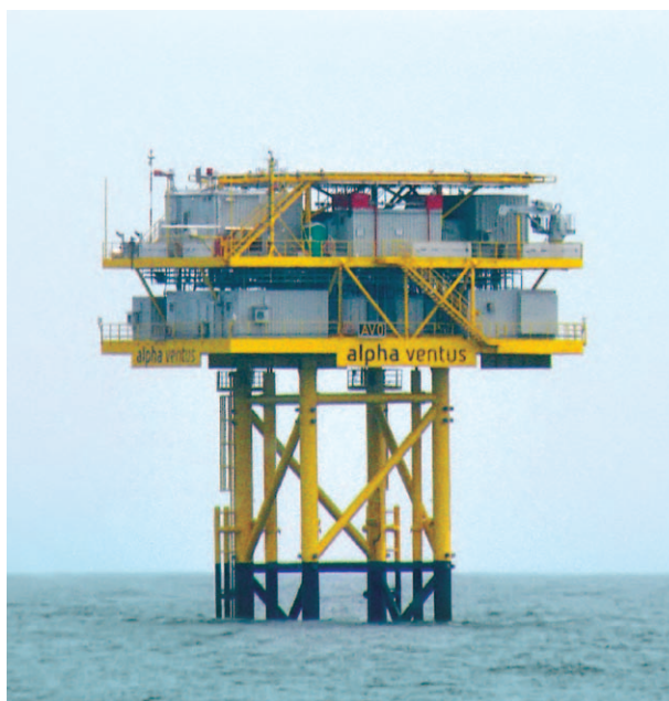
Ilustracja 2. Stacja transformatorowa na farmie Alpha Ventus na Morzu Północnym w Niemczech
