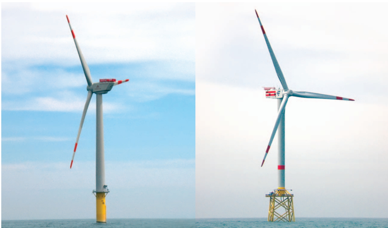
Ilustracja 1. Morskie elektrownie wiatrowe na fundamencie monopolowym (po lewej) i kratownicowym (po prawej) – MFW Alpha Ventus na Morzu Północnym na niemieckich obszarach morskich
