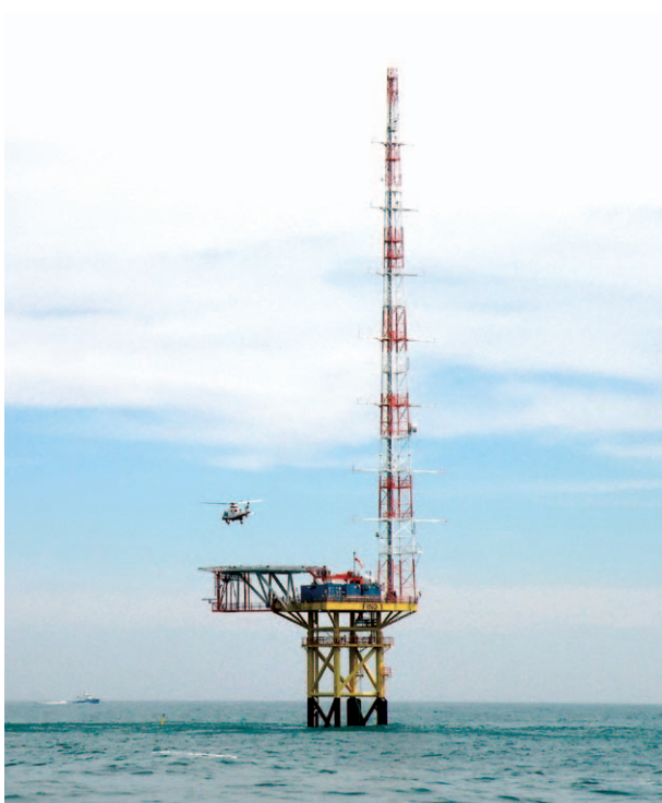
Ilustracja 3. Stacja badawcza Fino 1, z lądowiskiem helikopterów i zapleczem socjalnym, na farmie wiatrowej Alpha Ventus na Morzu Północnym w Niemczech
