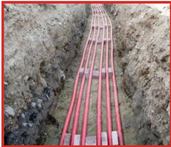
Układanie kabli w otwartym rowie (G.M.P. Contracting Services Ltd.)
