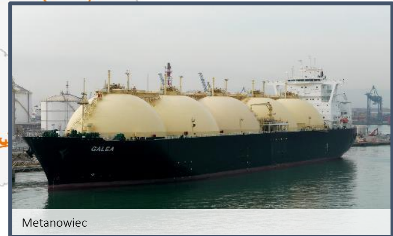
Terminal LNG w Świnoujściu
