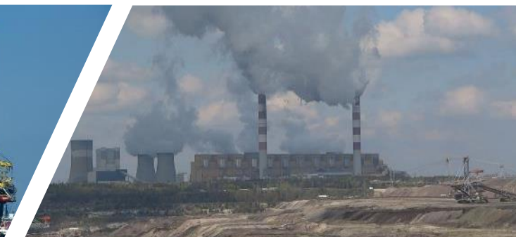
Elektrownia zasilana węglem brunatnym
