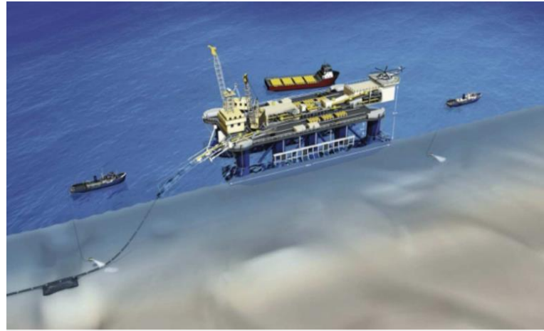
Układanie gazociągu na dnie morza
