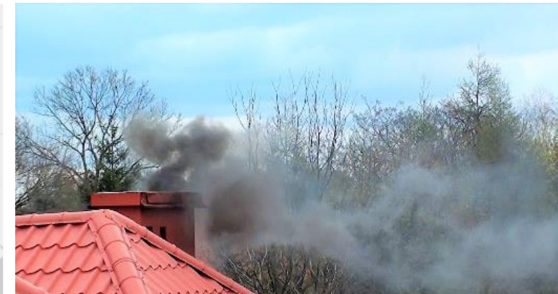
Komin, w którym spalane jest złej jakości paliwo
