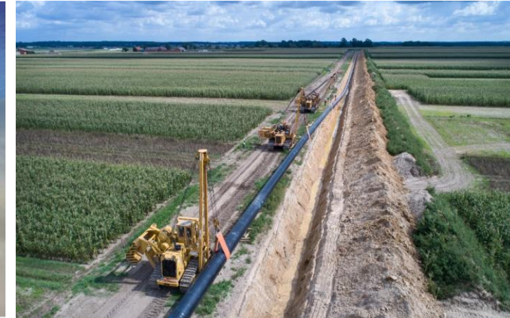
Instalacja gazociągu na lądzie
